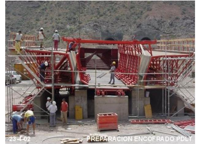
**Imagen 9. Viaducto. Preparación encofrado**
