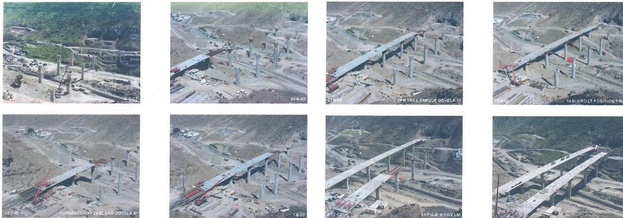
**Imagen 8. Viaducto. Proceso Constructivo**
